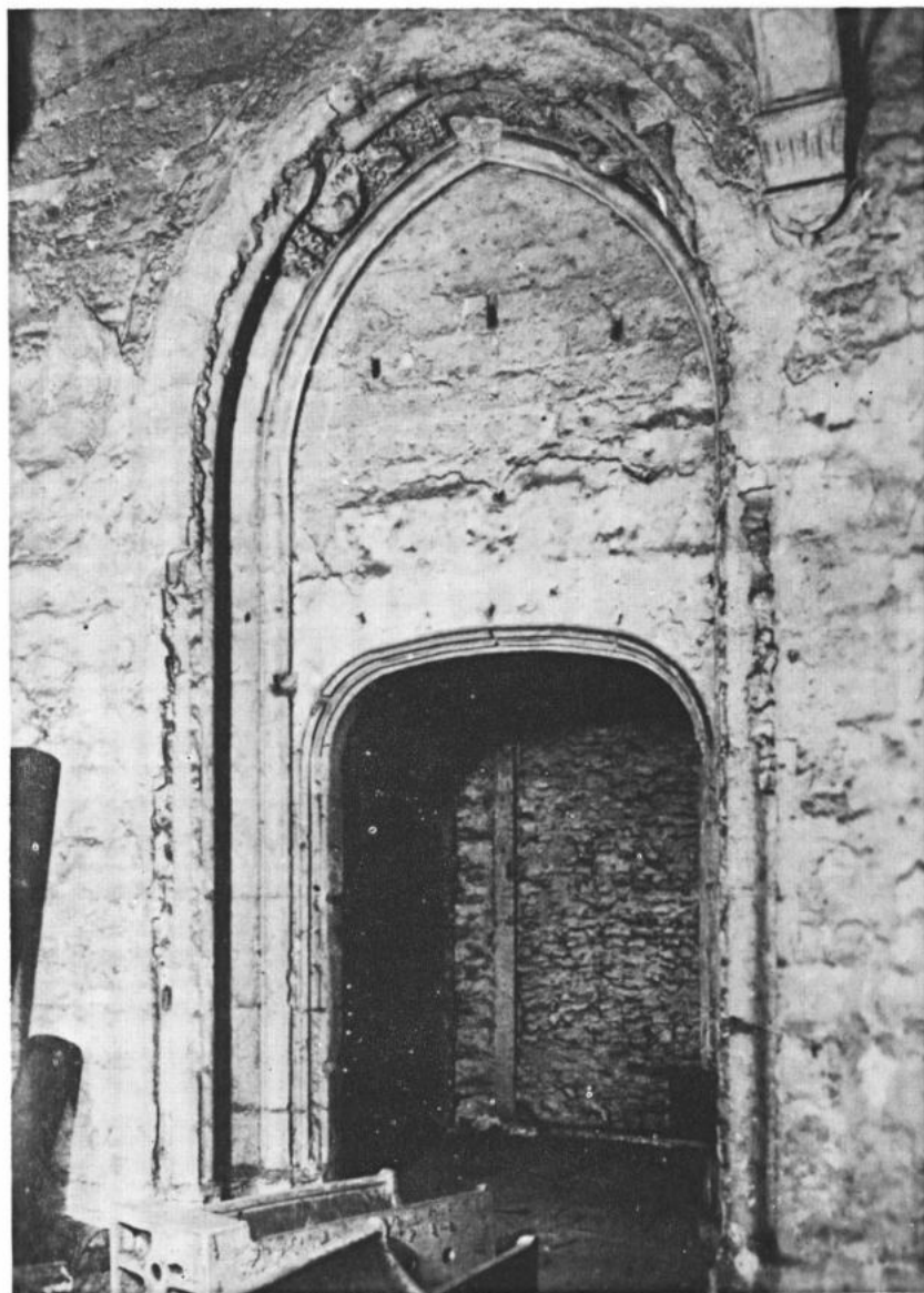
Afb. 30 — Kruisgang Zuid, ingang refter.
