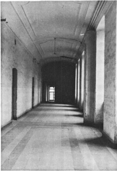
Afb. 54 — Dagkwartier (1753), gang op 1e verdieping, toestand 1953.
