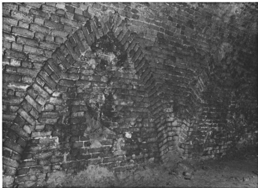
Afb. 29 — Keldering onder de grote koer, detail.
