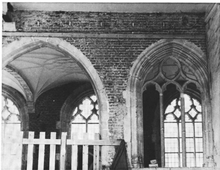
Afb. 20 — Kruisgang Oost, vanuit de Kapittelzaal met spoor van moerbalk (1955).
