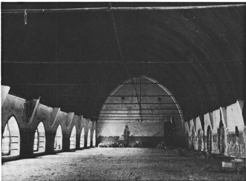
Afb. 40 — Refter, interieur na de herstelling van het dak.
