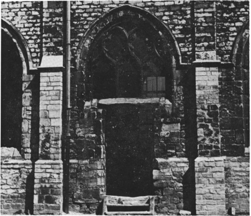
Afb. 17 — Kruisgang Oost, ingang Pandhof (1953).
