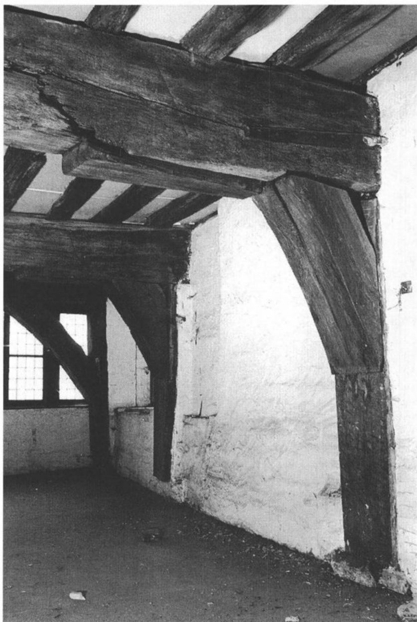
Afb. 8. Sporen van de laat-middeleeuwse houten binnenindeling op de tweede bovenverdieping (foto Stad Gent, Dienst Stadsarcheologie)
