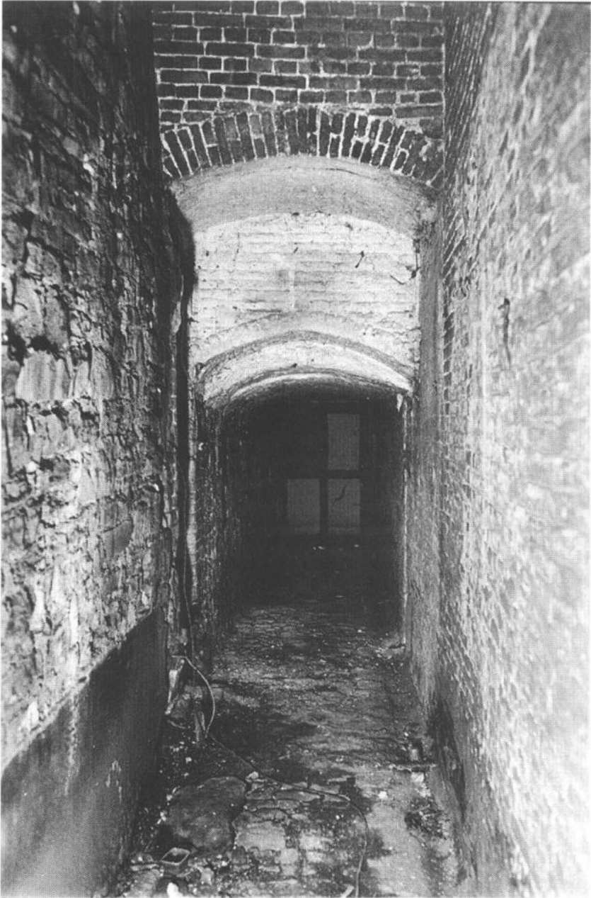
Afb. 5. De deels overwelfde steeg naast de noordgevel die nog grotendeels met Doornikse steen is opgebouwd (foto Stad Gent, Dienst Stadsarcheologie)
