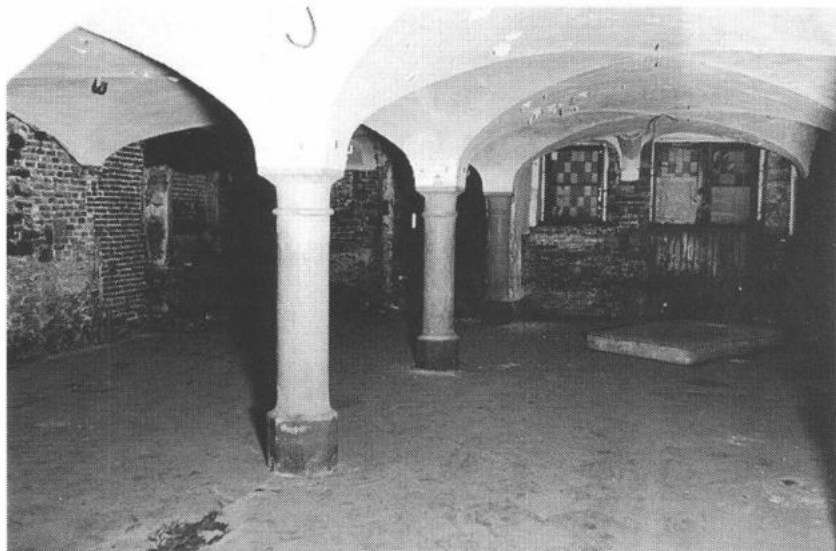
Afb. 6. De laat-middeleeuwse indeling en de overwelfing in de kelderverdieping (foto Stad Gent, Dienst Stadsarcheologie)
