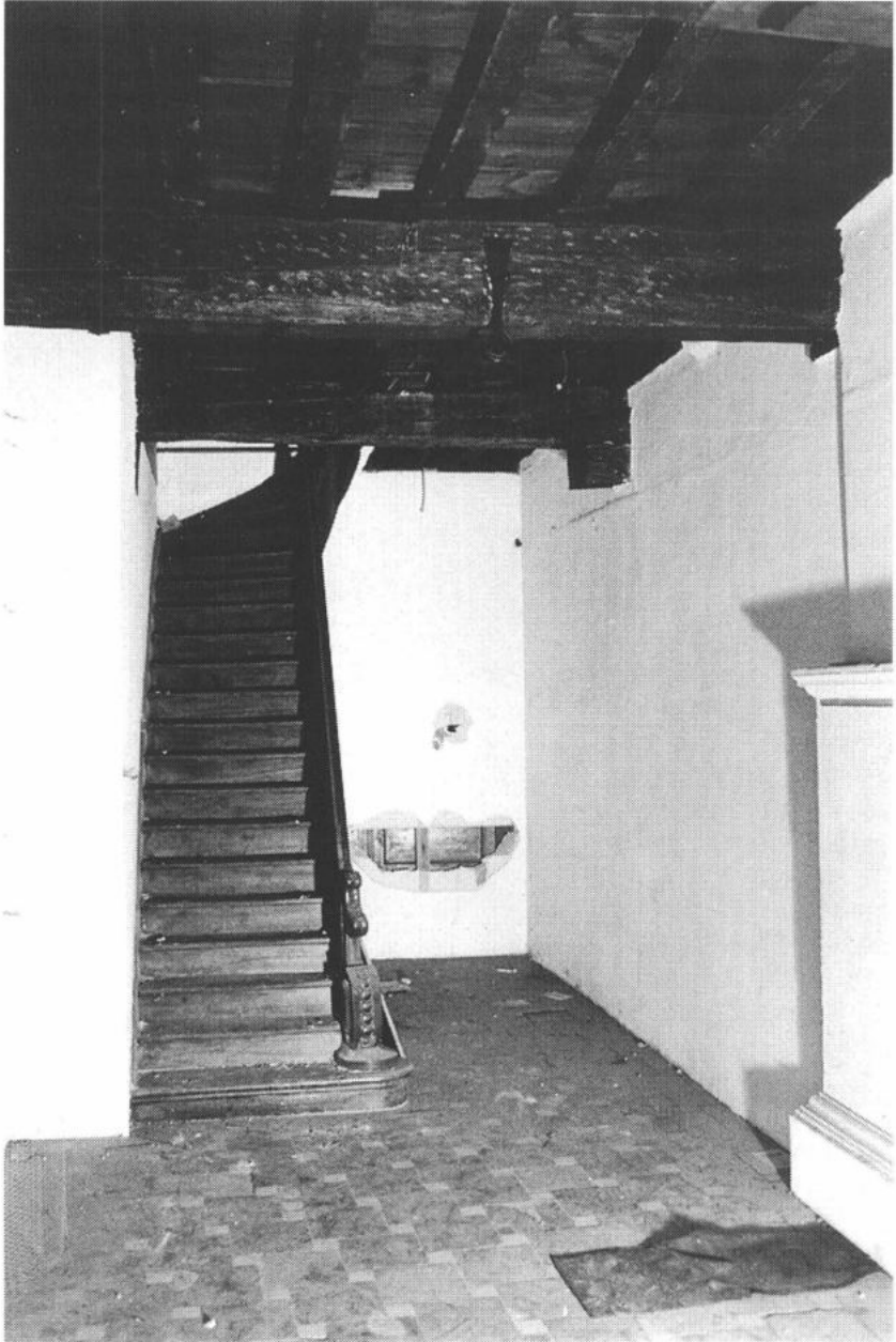
Afb. 12. Gezicht in de inkomhal met de laat-middeleeuwse houten draagstructuur, de 18de-eeuwse monumentale trap met versierde trappaal en de bijhorende bevoering (foto Stad Gent, Dienst Stadsarcheologie)
