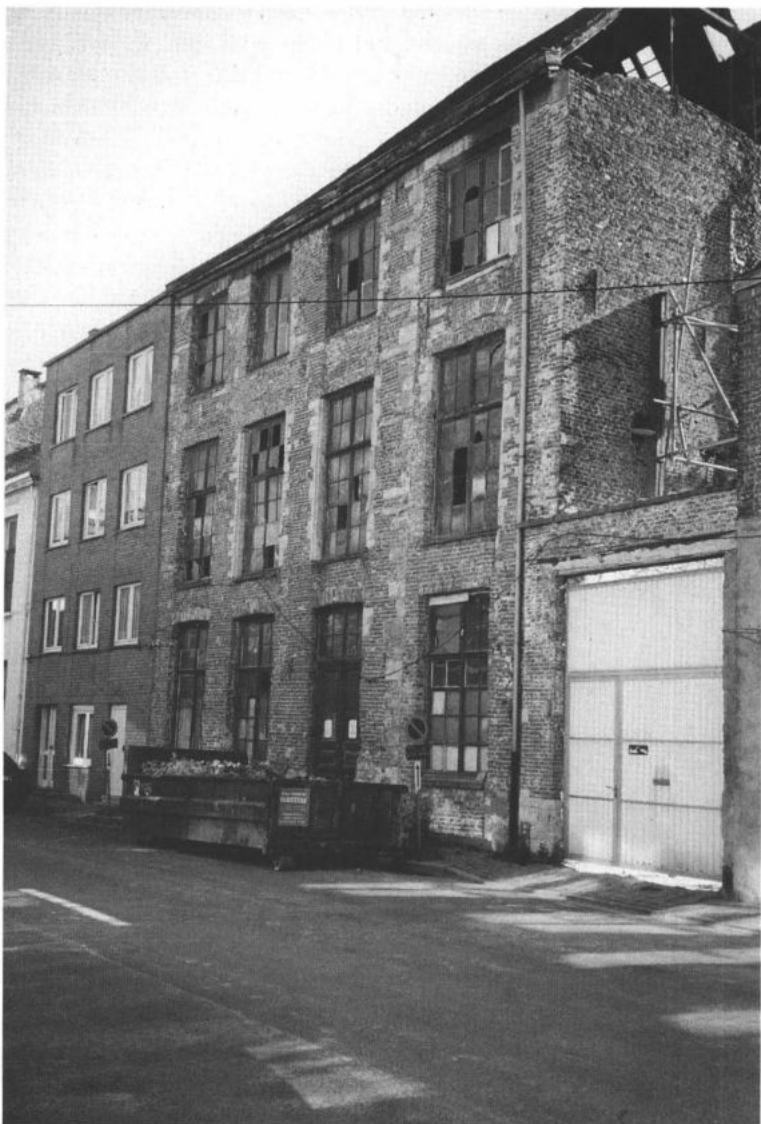
Afb. 10: In het huis Sanderswal 8 was de structuur van de noordvleugel het best bewaard tot aan de instorting van dit pand in 1993: natuurstenen hoekblokken geven de bouwnaad aan tussen de noordvleugel en de latere westelijke uitbreiding met één travee (Foto M. Helskens, Gent)
