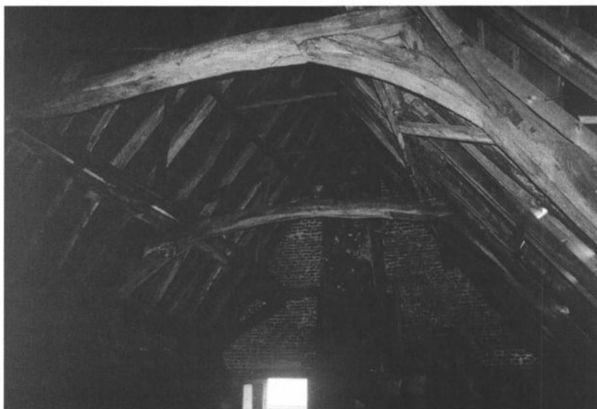
Afb. 12: De 15de-eeuwse dakconstructie van de oostvleugel, behouden in Prinsenhof 105 (Foto Dienst Stadsarcheologie, Gent)
