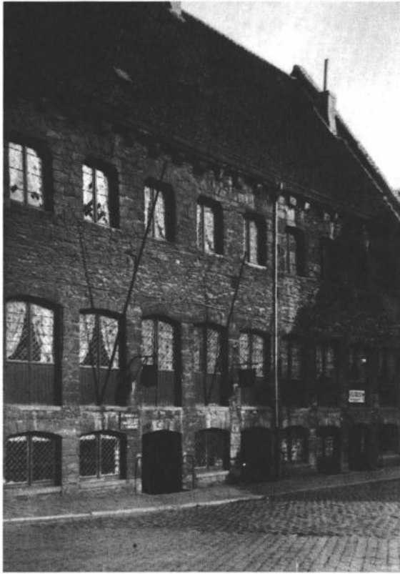
Afbeelding 25 In lokale dagbladen kon de restauratie van de voorgevel van de Spijker op veel bijval rekenen. De krant Flandre liberale (9 oktober 1904) meende dat de restauratie pas compleet zou zijn indien het voetpad aan de Hooiaard werd verlaagd: "On aurait de cette manière l'aspect complet du bâtiment tel qu'il était avant l'exhaussement du sol de la rue." (SAG., Reeks SCMS, Foto's, doos 165, Hooiaard, nr. 2389)
