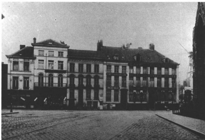
6. Het voormalige Coelsteen alias Hotel de la Nouvelle Poste aan de Kleine Korenmarkt, omstreeks 1906 (Stedelijke Commissie voor Monumenten en Stadsgezichten, Gent)
