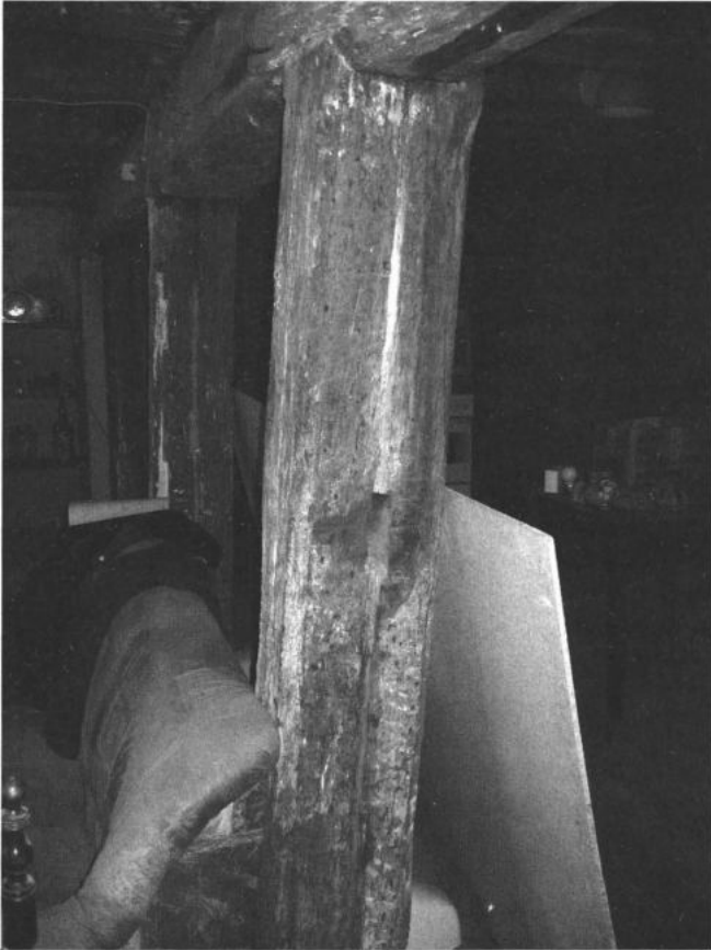
Afbeelding 6 Aan een variabel aantal zijden van de standvinken zitten gleuven die ruim twee centimeter breed zijn. In sommige gevallen, zoals te zien op de afbeelding, hebben de gleuven een verbreding tot een rechthoekige opening. Vermoedelijk werden in de gleuven schotten geschoven die, waar nodig, konden vastgezet worden met dwarsbalken, waarvoor in de standvinken openingen werden voorzien (Eigen foto, mei 2006)
