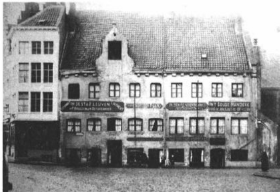
Afbeelding 3 Deze foto, die aan de hand van de namen van de uitbaters op de uithangborden kon gedateerd worden in 1898, biedt het oudste waarheidsgetrouwe beeld van de Spijker. De voorgevel draagt een eenheidsbepleistering en is getooid met een dakkapel die naar vormgeving een nauw verwantschap vertoont met de klokgevels. De verschillende vorm van de vensteropeningen valt samen met de opdeling van de Spijker in twee woningen omstreeks 1709 (SAG., Reeks SCMS, Foto's, doos 165, Hooiaard, nr. 2395)
