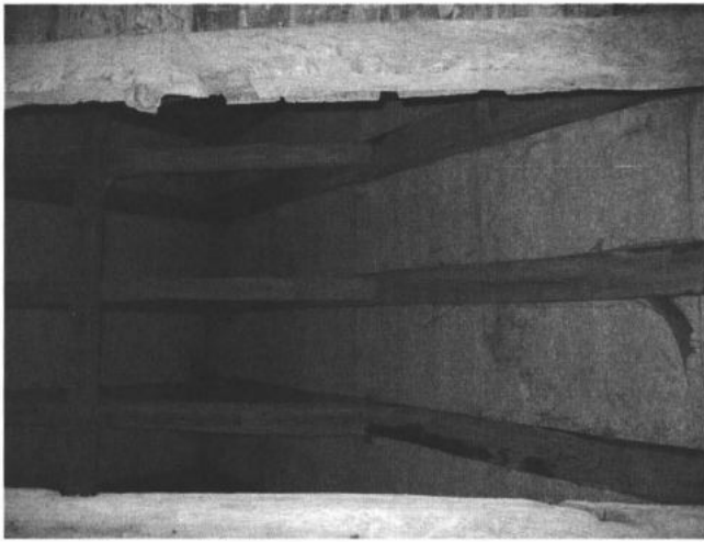
Afbeelding 8 De spantbenen van de sporenkap in het voorhuis van de Spijker zijn onderling niet met elkaar verbonden, tenzij door de hanenbalken, want er is geen nokverbinding (Eigen foto, mei 2006)
