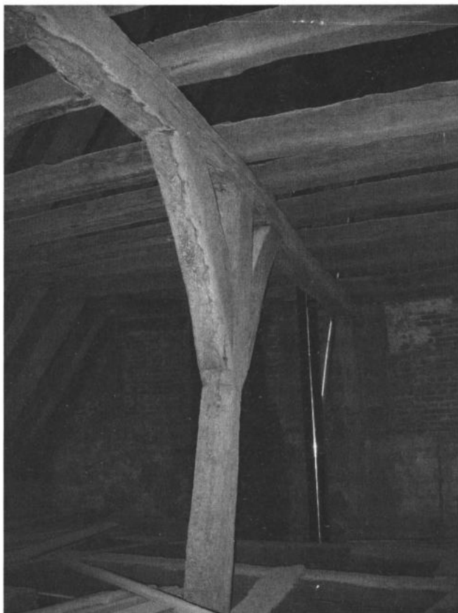
Afbeelding 9 Op de zoldervloer werden centrale standvinken met zijdelingse schoren geplaatst ter ondersteuning van de onderslagbalk. De zoldervloer werd recent verwijderd maar op de onderliggende balkenroosting zijn nog steeds drie oorspronkelijke standvinken bewaard gebleven (Eigen foto, mei 2006)
