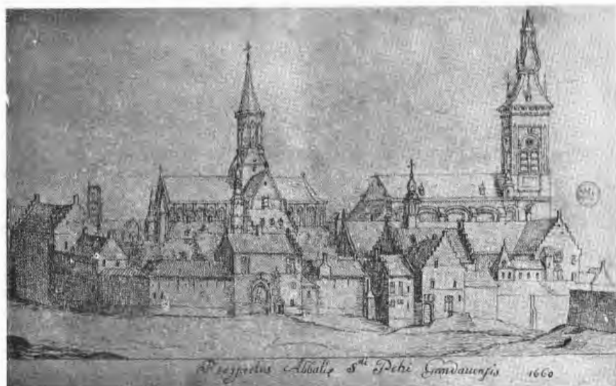
Fig. 5 — Tekening van 1660 (Atlas Goedgebuer, Bibl. Univ. Gent), toestand vóór koepel en W.-gevel der abdijkerk werden opgebouwd. De refter (met dakruiter), toestand vóór de uitbreiding naar het W. toe. Zie afstand tussen dakruiter en W.-gevel en afwezigheid van schouwen op het dak van de refter.
