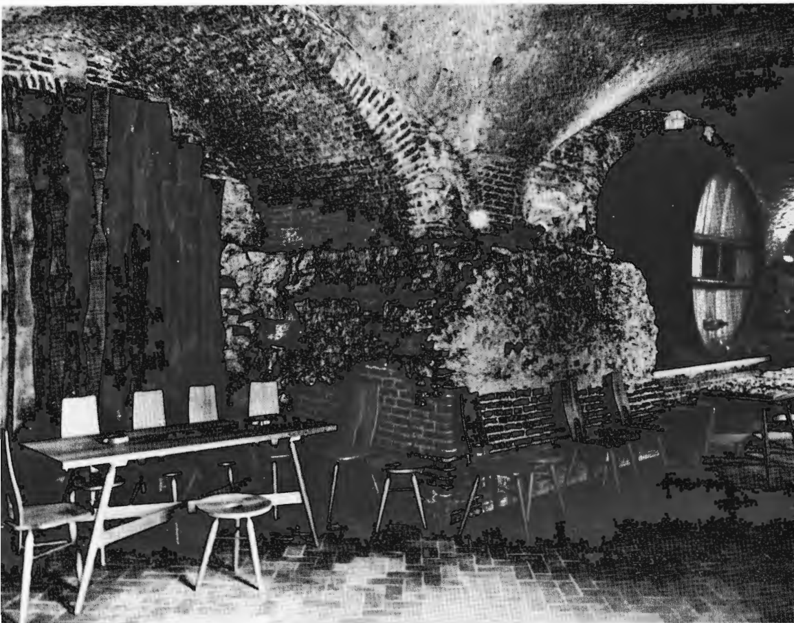
Afb. 19 — Kelder onder de zuidkooromgang van de barokkerk
