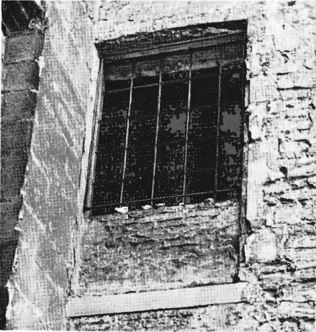
Afb. 15 — Venster in de Noordpandmuur
