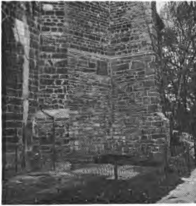
Afb. 22 — Steunberen van de O.L.V.-kapel
