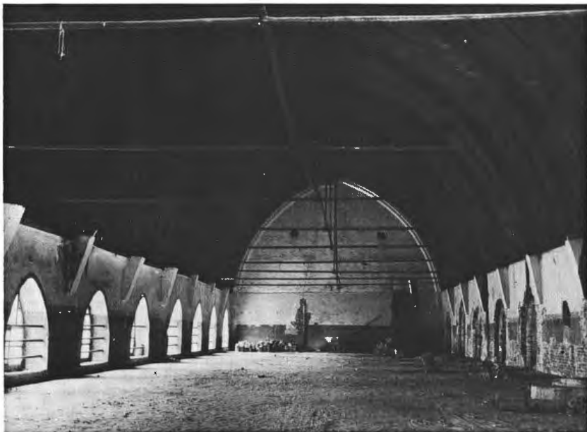
Afb. 40 — Rafter, interieur na de herstelling van het dak.
