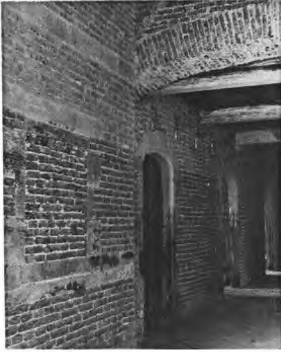
Afb. 52 — Dagkwartier (1635), gang op 2e verdieping, toestand 1953.
