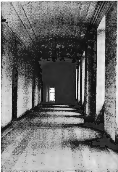
Afb. 54 — Dagkwartier (1753), gang op 1e verdieping, toestand 1953.
