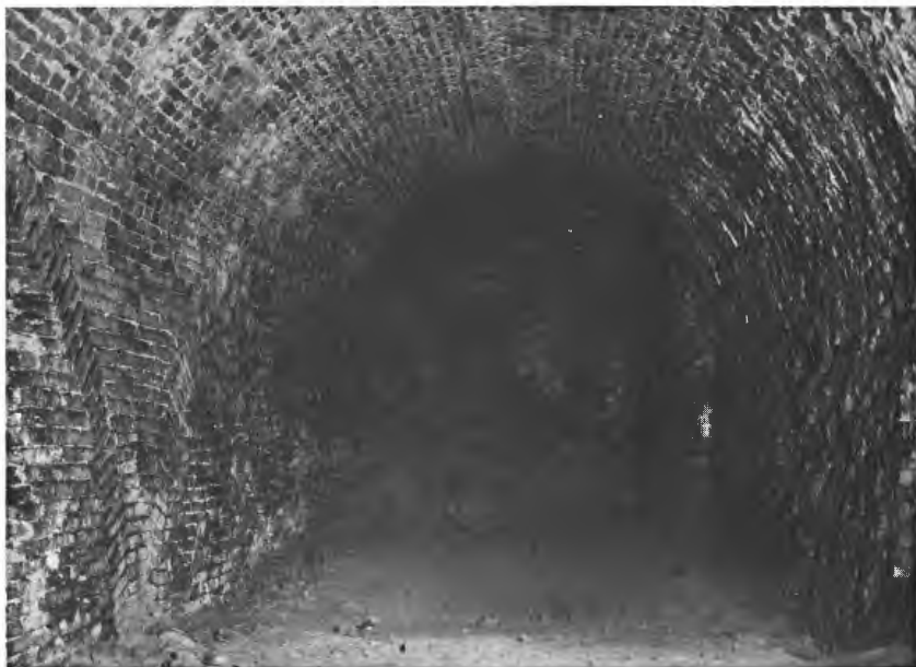
Afb. 28 — Keldering onder de grote koer.
