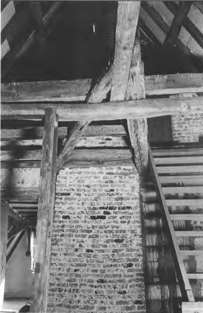
Afb. 9. De laat-middeleeuwse dakconstructie omheen de centrale schoorsteenpijp (foto Stad Gent, Dienst Stadsarcheologie)
