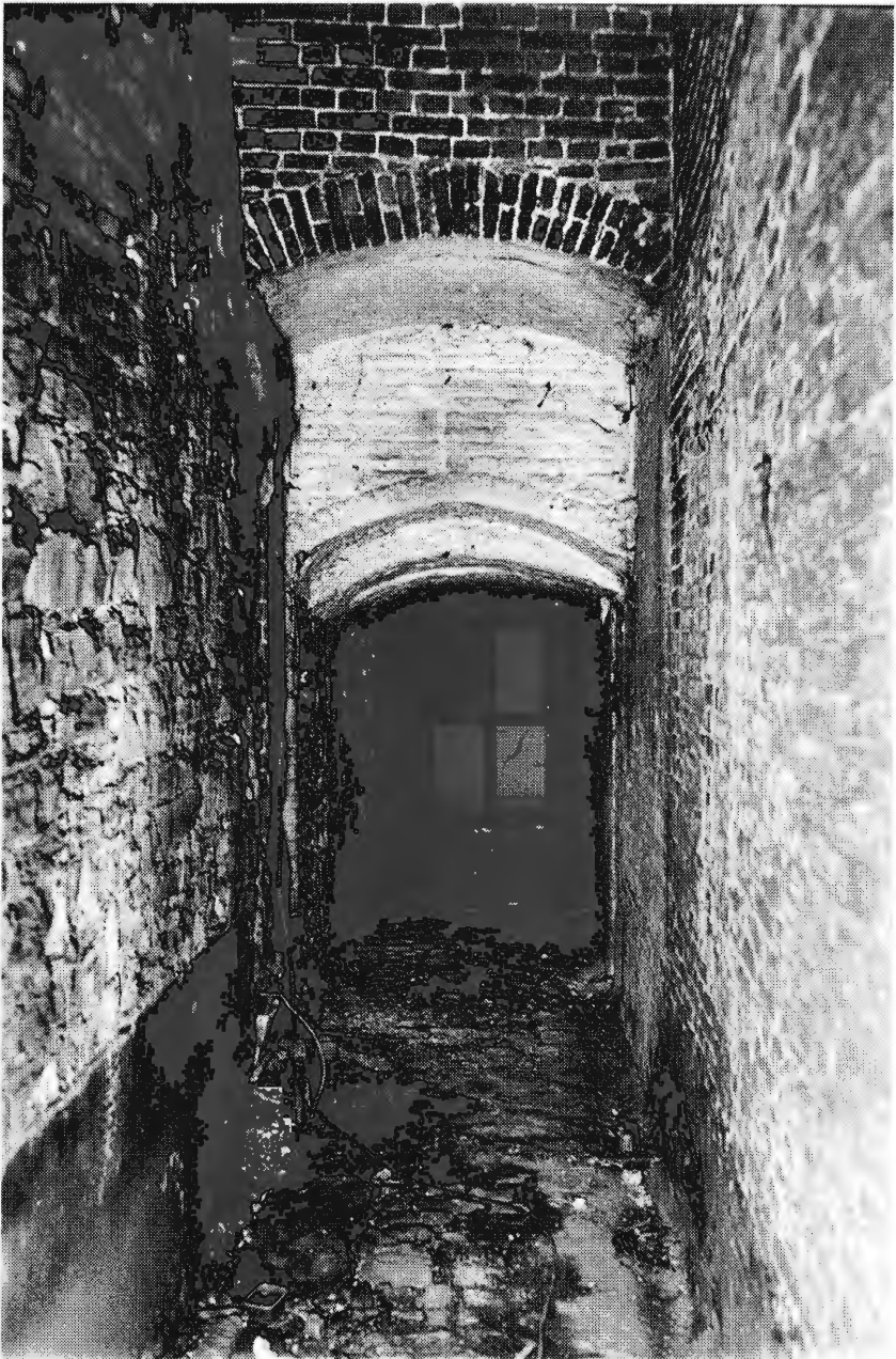
Afb. 5. De deels overwelfde steeg naast de noordgevel die nog grotendeels met Doornikse steen is opgebouwd (foto Stad Gent, Dienst Stadsarcheologie)
