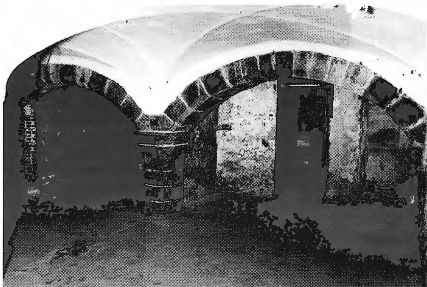
Afb. 3. Een kolom en segmentbogen in de kelderverdieping getuigen van de oudste bouwfase (foto Stad Gent, Dienst Stadsarcheologie)
