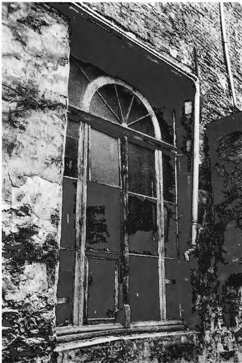
Afb. 15. Vensteropening met schrijnwerk in empiretraditie, 1830, bij de bel étage aan de erfzijde (foto Stad Gent, Dienst Stadsarcheologie)
