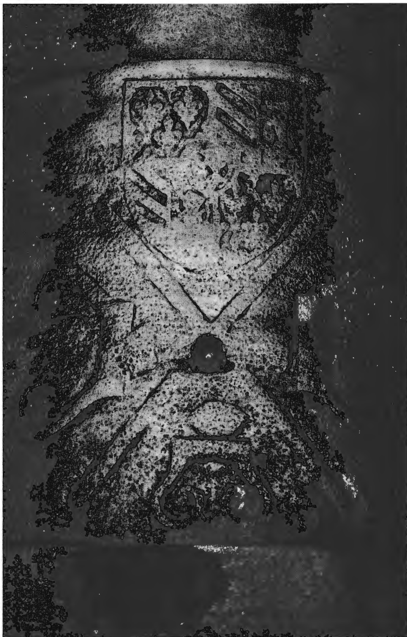
Bourgondische heraldische kentekens rond het zundgat van de Dulle Griet. Op de voorgrond één van de acht pengaten in de 2 e hoepel. Foto M. BEYAERT, 03.1998.
