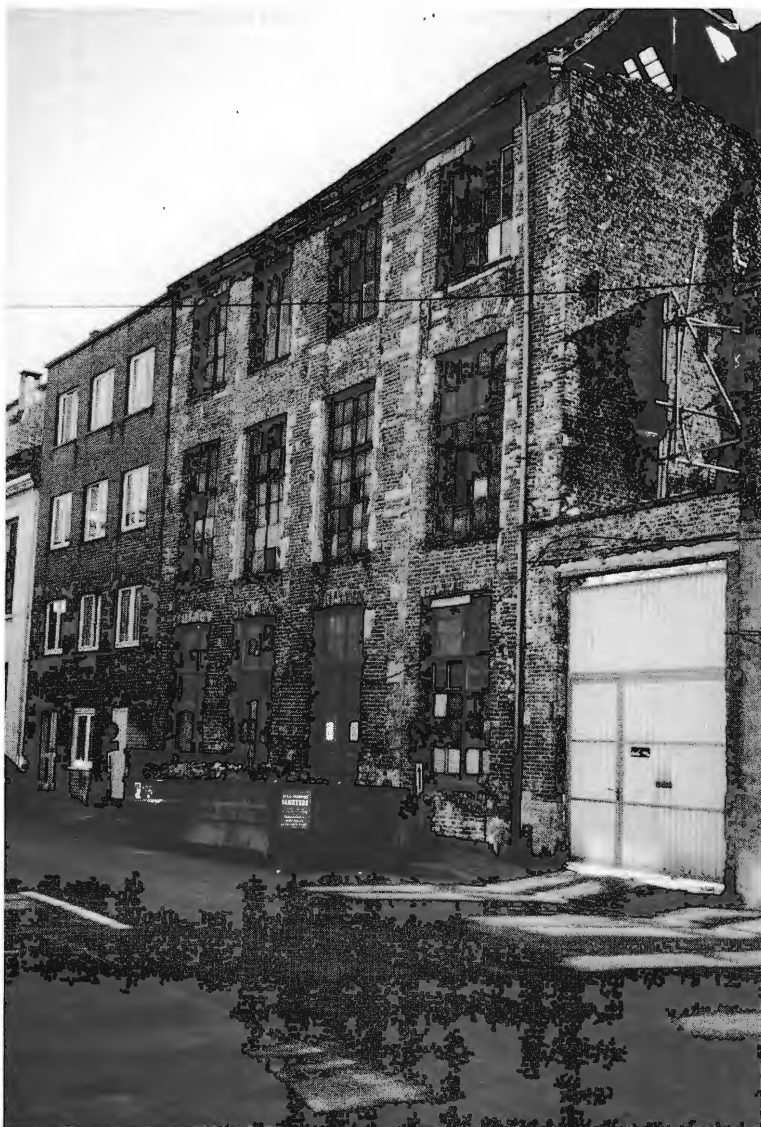
Afb. 10: In het huis Sanderswal 8 was de structuur van de noordvleugel het best bewaard tot aan de instorting van dit pand in 1993: natuurstenen hoekblokken geven de bouwnaad aan tussen de noordvleugel en de latere westelijke uitbreiding met één travee (Foto M. Helskens, Gent)
