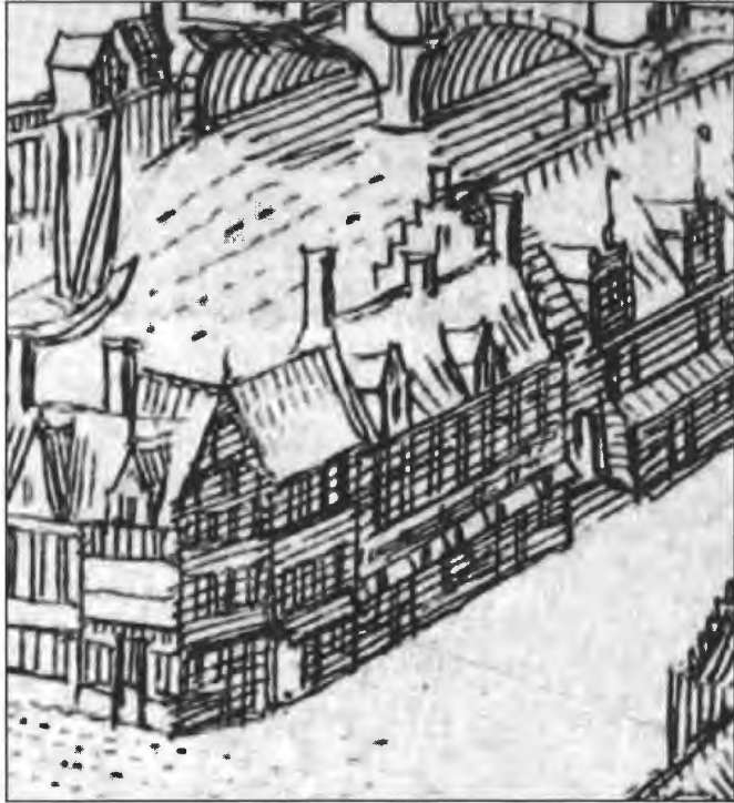
Afbeelding 16 De Spijker wordt weergegeven in vooraanzicht en draagt een zadeldak met twee schoorstenen op beide zijmuren en een schoorsteen centraal op de daknok. Enkel de noordelijke zijmuur heeft een trapgevel. Aan de straatzijde staan boven de daklijst twee dakkapellen (uit: A. SANDERUS, Flandria Illustrata . Amsterdam, 1640-1641, volume 1, p. 127, detail prent 'Ecclesia parochialis Sti. Nicolai uxta forum frumentarium Gandavi'.)
