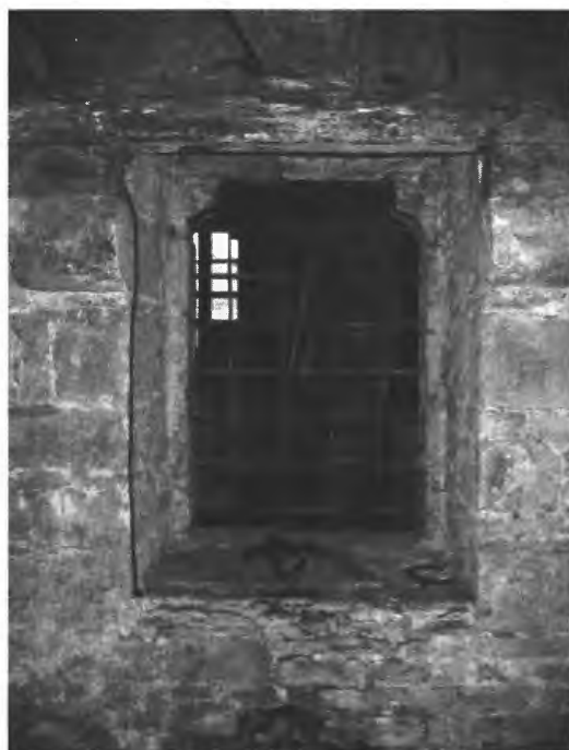
Afbeelding 5 In de voormalige achtergevel bleef een schouderboogvormige vensteropening in haar oorspronkelijke toestand bewaard. De opening wordt afgeschermd door smeedijzeren dievenstaven. Het traliewerk telt acht horizontale staven die door vier verticale staven schieten (Eigen foto, november 2005)
