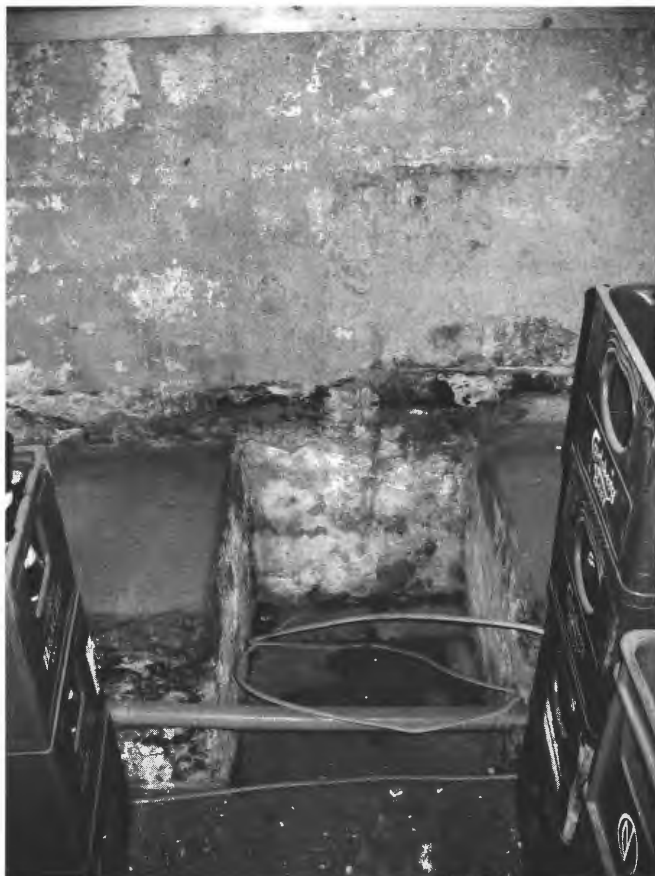
Afbeelding 13 In de dikte van de zuidelijke zijmuur staan twee verdiepte vensterbanken die volledig uit breuksteen werden vervaardigd. Ze zijn respectievelijk 47 centimeter (vooraanzicht, links) en 54 centimeter (vooraanzicht, rechts) breed. De muurplint in breuksteen is 48 centimeter hoog en draagt een onderdorpel in breuksteen van gemiddeld 10 centimeter hoog (Eigen foto, maart 2006)
