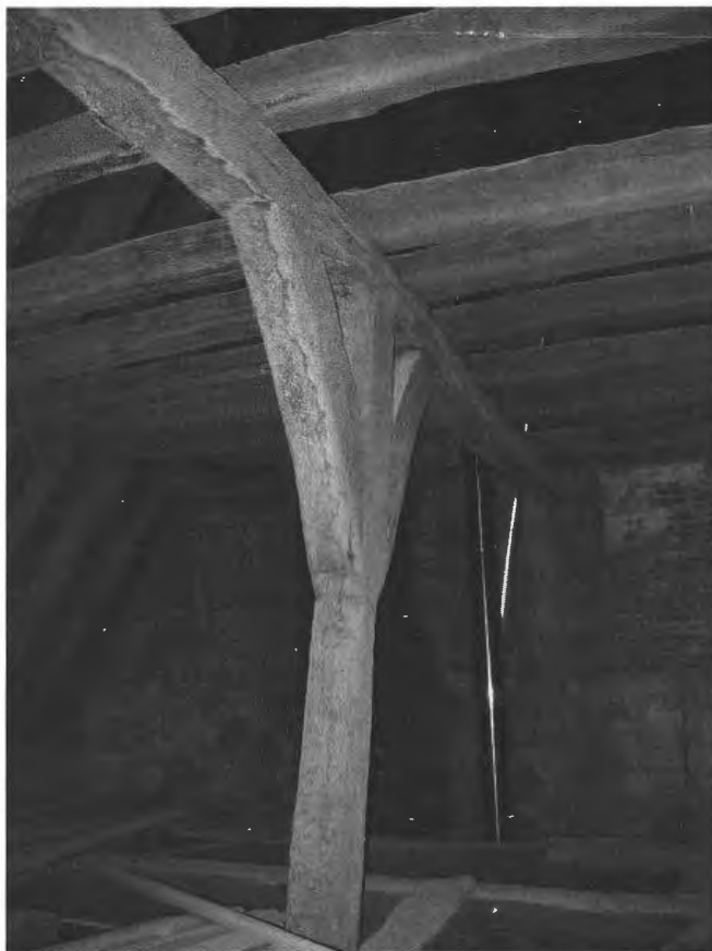
Afbeelding 9 Op de zoldervloer werden centrale standvinken met zijdelingse schoren geplaatst ter ondersteuning van de onderslagbalk. De zoldervloer werd recent verwijderd maar op de onderliggende balkenroostering zijn nog steeds drie oorspronkelijke standvinken bewaard gebleven (Eigen foto, mei 2006)
