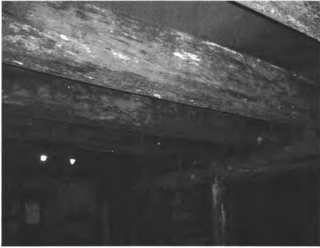
Afbeelding 7 Haaks op de onderslagbalken rusten de dwarsbalken die vrij dicht bij elkaar werden geplaatst. De dwarsbalken dragen nog sporen van een witte bekalking en vertonen de kenmerkende afgeschuinde vorm aan de hoeken, zoals te zien is op de eerste verdieping in het voorhuis van de Spijker (Eigen foto, november 2005)
