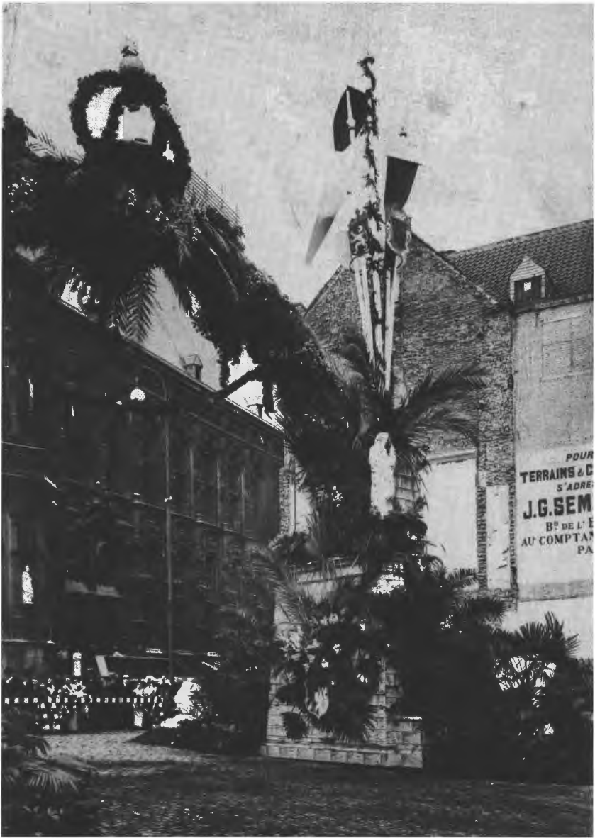
2. Foto met zicht op de afbraakwerken voor de aanleg van de Belfortstraat tegen de achtergrond van het stadhuis. Op de voorgrond een niet nader bepaalde triomfboog of inhuldiging, op de achtergrond rechts een publicitaire schildering waarmee "J.G. SEM(EY)" de terreinen en kavels te koop aanbiedt. De foto is gedateerd 20 juli 1902 (Stadsarchief Gent, Fotoverzameling Stedelijke Commissie van Monumenten en Stadsgezichten, nr. 541)
