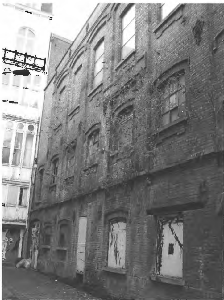
10. De gevel aan de Plattenberg, 2005, Foto Joris Nauwelaerts
