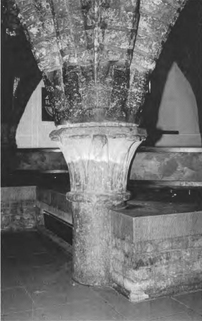
Fig. 3: Huis Appelmarkt 2 (H 1): middenkolom van witte natuursteen met gewelfaanzet van Doornikse kalksteen
