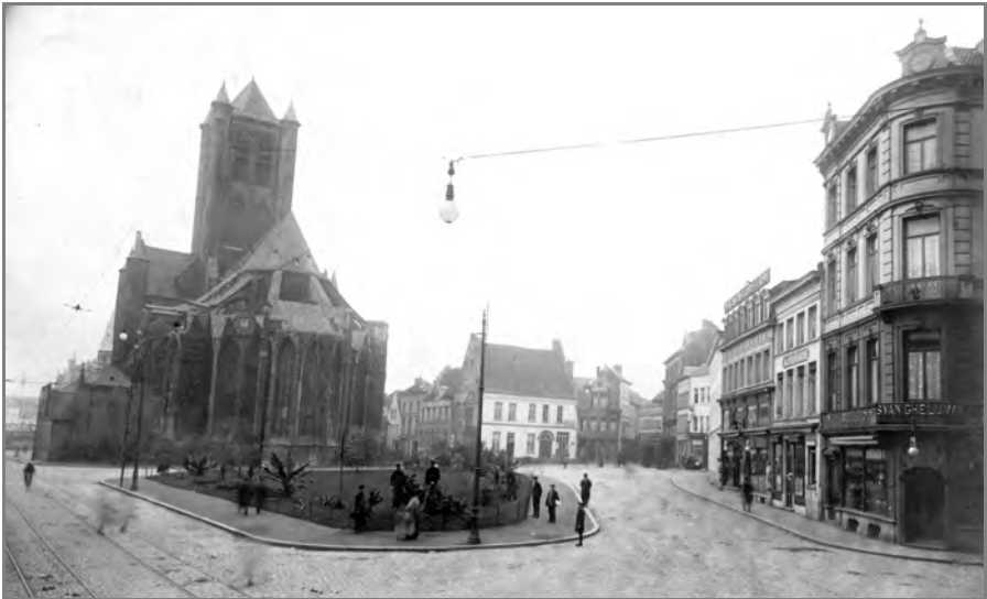
Afbeelding 15. De noordwand van de Korte Ridderstraat vóór de sloop in 1960-1964 (Stad Gent, Stadsarchief)
