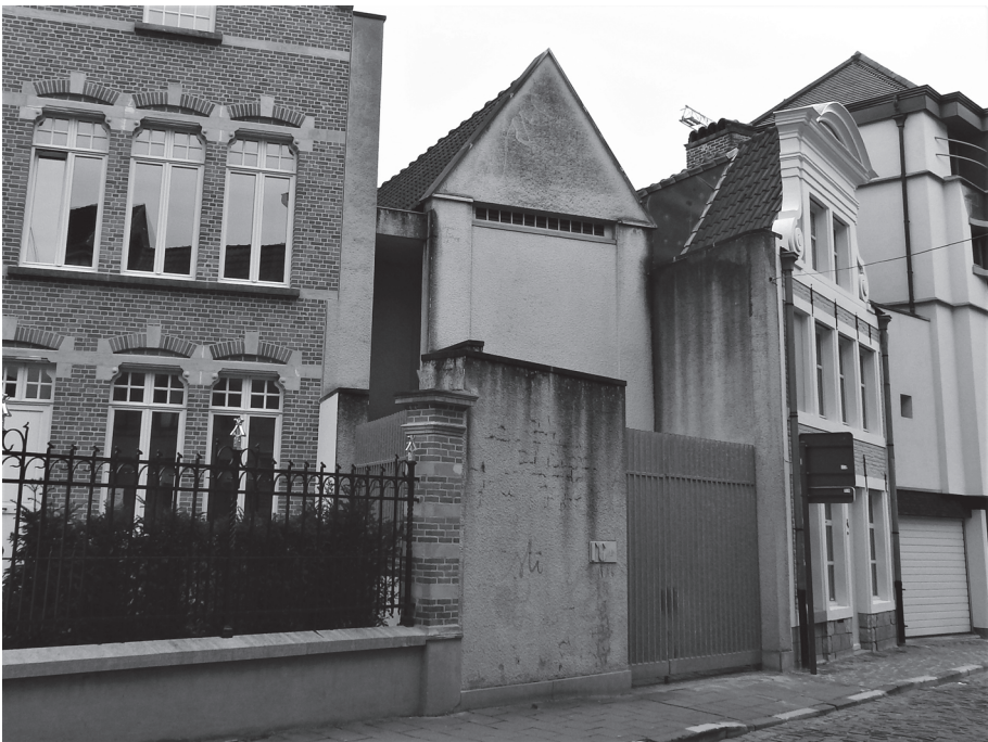
Abbeelding 29. Elektricitetscabine, Prinsenhof (Foto Evert Vandeweghe, 2018).
