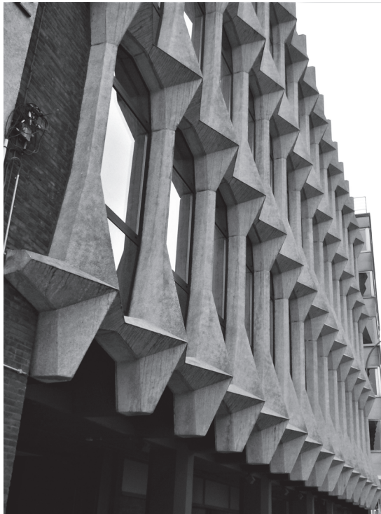
Afbeelding 22. Radiogebouw BRT 2 - Oost-Vlaanderen, Martelaarslaan (Foto Evert Vandeweghe, 2017).
