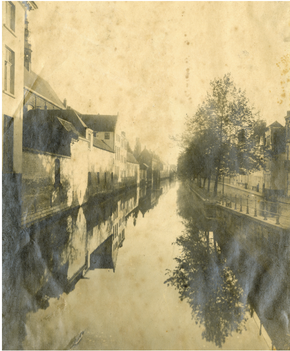
[3] De Oude Houtlei ter hoogte van het Alexianenklooster (Stad Gent, Archief Gent, SCMS_FO_7984)
