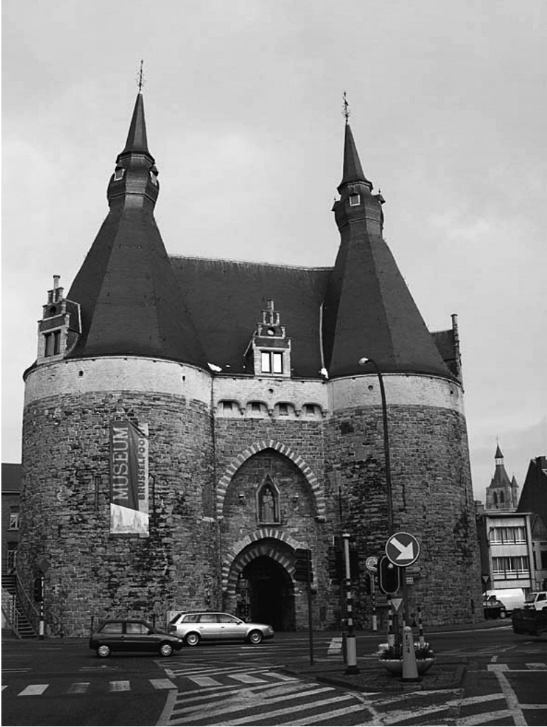
Afbeelding 5. – De Brusselsepoort in Mechelen, gebouwd in de veertiende eeuw, met centraal de poortdoorgang die aansluit op de uitvalsweg richting Brussel (foto Bart De Smet).
