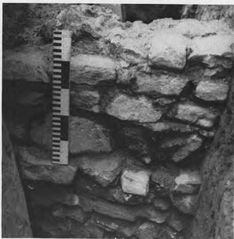
AFB. 13. — Detail van muur 6.
