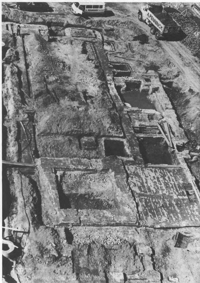
De opgegraven funderingen van het belfort en de halle.
