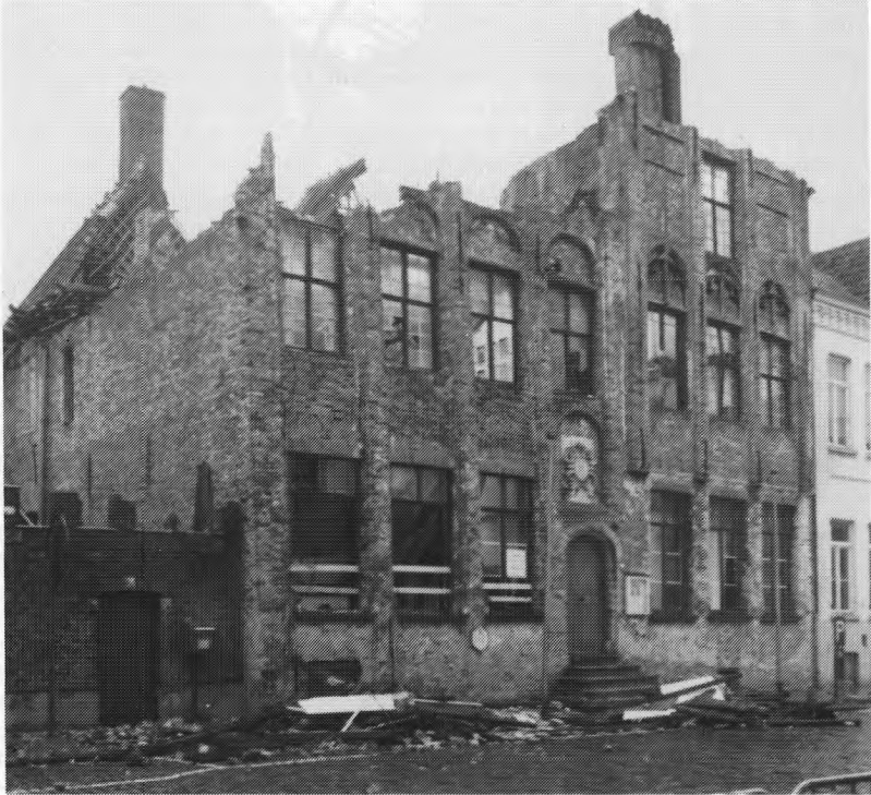
Damme. De Grote Sterre gedeeltelijk ingestort op 26 februari 1990. (foto L. Devlieghe).
