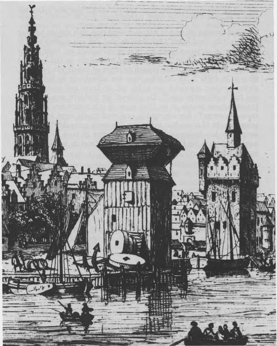
Afb. 9. De dubbele niet draaibare havenkraan met gesloten kraanhuis te Antwerpen in 1644. Het toestel werd in 1548 opgericht en in 1811 afgebroken. Ets gemaakt door J. Linnig (19de eeuw), naar een schilderij van Bonaventura Peeters. Detail. Stad Antwerpen, Museum Plantin-Moretus en Prentenkabinet. Verzameling Stedelijk Prentenkabinet, cat. nr. M II/L. 366-368. Copyright.
