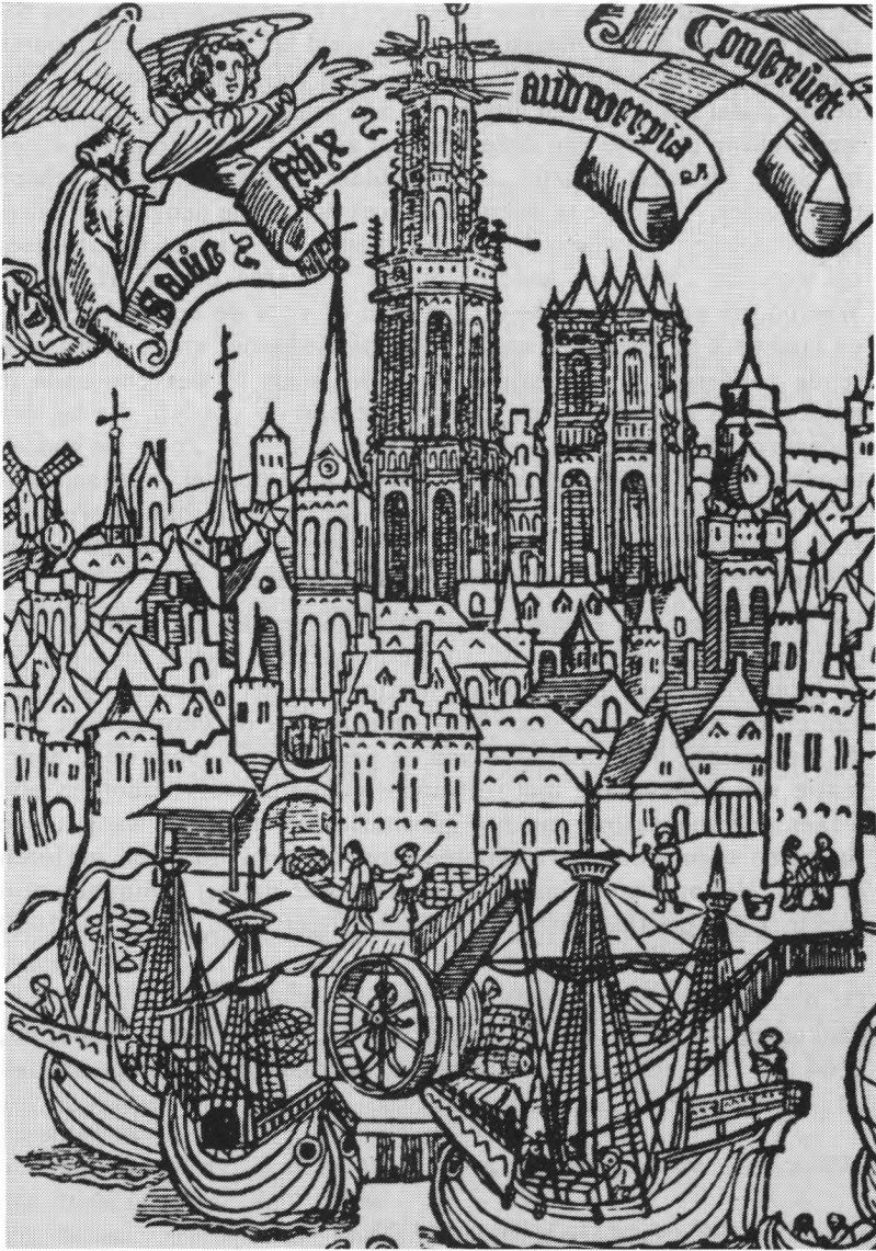
Afb. 8. De draaibare havenkraan te Antwerpen in werking, 1515. Anoniem meester. Redegezicht. Houtsnede (in : Benedictus de Opiitii, Loeflicken Sanck , Antwerpen, Jan de Gheet, 1515). Stad Antwerpen, Museum Plantin-Moretus en Prentenkabinet. Verzameling Museum Plantin-Moretus. Copyright.
