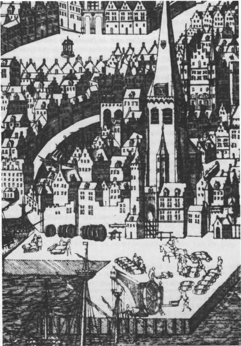
Afb. 7. Het draaien van de kraan aan de staart door een kraankind. Detail van een anoniem gezicht op Antwerpen, ca. 1532. Amsterdam, Rijksmuseum-Stichting OB 4318.
