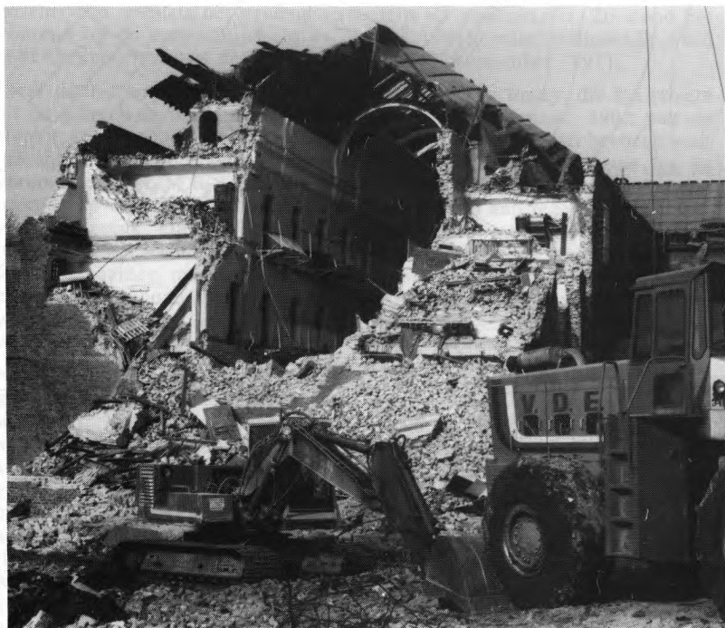
De mannengevangenis tijdens de slooping (uit het zuiden).
