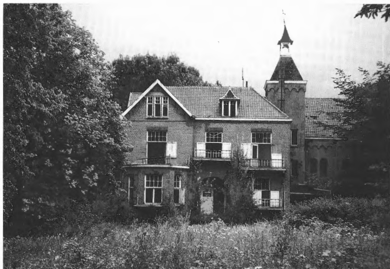
Het noviciaat van de "Soeurs de la Providence de Rouen" in zijn huidige vervallen toestand. (Foto Koen Rotsaert, 2004)
