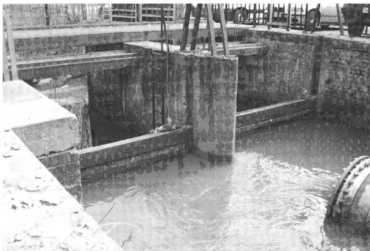
De sluis bij het Klein Seminarie in maart 2004. Hier stroomt de Collevijverbeek in de Mandel. Door deze sluis kon in de negentiende eeuw het waterpeil tussen het Klein Seminarie en het Grote Bassin geregeld worden.
