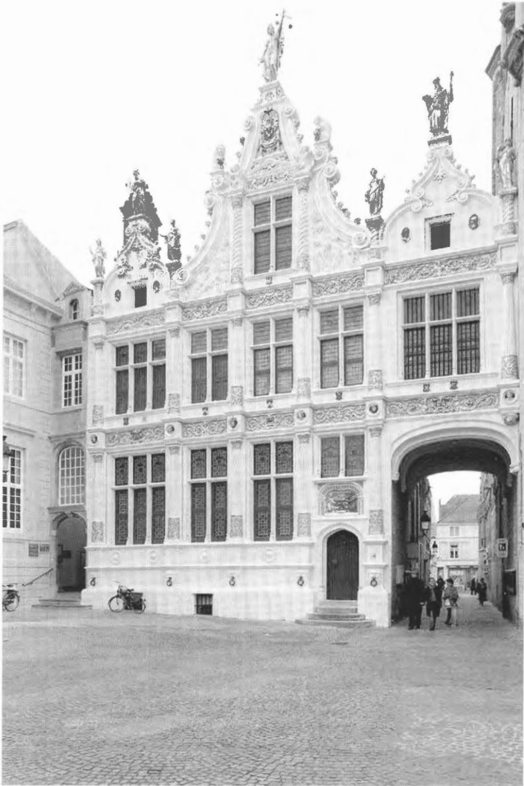
1. De gerestaureerde gevel van de Burgerlijke Griffie © Brugge, Cel Fotografie, J. Termont
