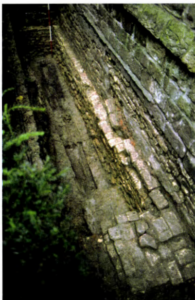
Afb. 2. Funderingscontrole van de noordelijke (schip)muur van de Sint-Jacobskerk. Onderaan ijzerzandsteen overgaand in baksteen, bovenaan het heropbouwvolume. Ongeveer centraal bemerkt u de zijkant van een, achteraf dichtgemaakte, doorgang.
