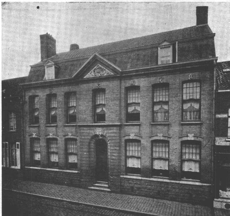
Immeuble habité par Pierre Jacques François Cadock et construit par lui en 1777. La façade - etc, quelque peu modernisée.
