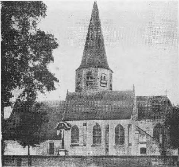
FIG. 19. De in 1892 gedeeltelijk afgebroken kerk vanuit het zuiden.
