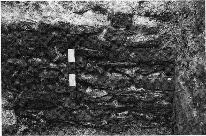
Veldstenen fundering van de muurtoren
