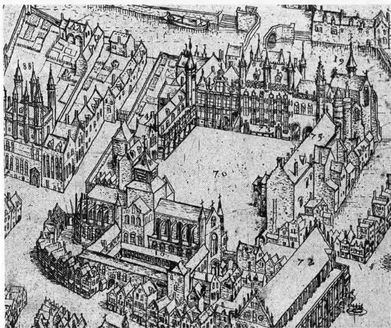
De Burg op het stadsplan van Marcus Gerards, 1562. Onderaan o.a. de Sint-Donaaskerk met de kloostergebouwen op de noordzijde. Op de linkerkant, ongeveer in het midden, de vierzijdige toren van de oostelijke burchtmuur.
