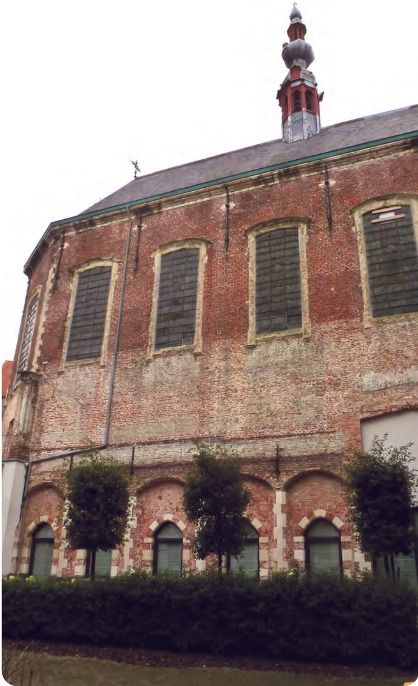
Afb. 6. Dezelfde kapel gezien vanop de opgevulde Oude Houtlei (foto 2021). De benedenverdieping – de eigenlijke vestmuur – is hier gedeeltelijk open gemaakt en voorzien van kleinere vensters.
