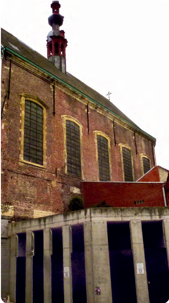
Afb. 5. Actueel gezicht op de alexianenkapel op een foto in 2021 genomen op de binnenkoer van de Residentie Colleghof aan de Sint-Michelstraat. De typisch barokke kapelvensters werden veel hoger dan normaal aangebracht. We zien ze in een schijnbare verdieping, beneden geflankeerd met betonnen nutsruimten. Deze werden tegen de vroegere vest aangebouwd. Voor een verdere beschrijving van deze eigenaardige site met verplaatste barokke poortomlijsting (niet in beeld): zie Devriese (2019).
