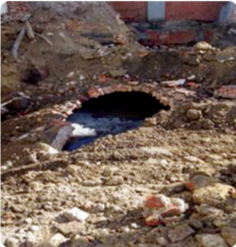
Afb. 4. Overwelfd gedeelte, bloot gelegd in de omgeving van de Hubert Frère-Orbanlaan (vermoedelijk Hendrik Waelpuutstraat, foto 2019).
