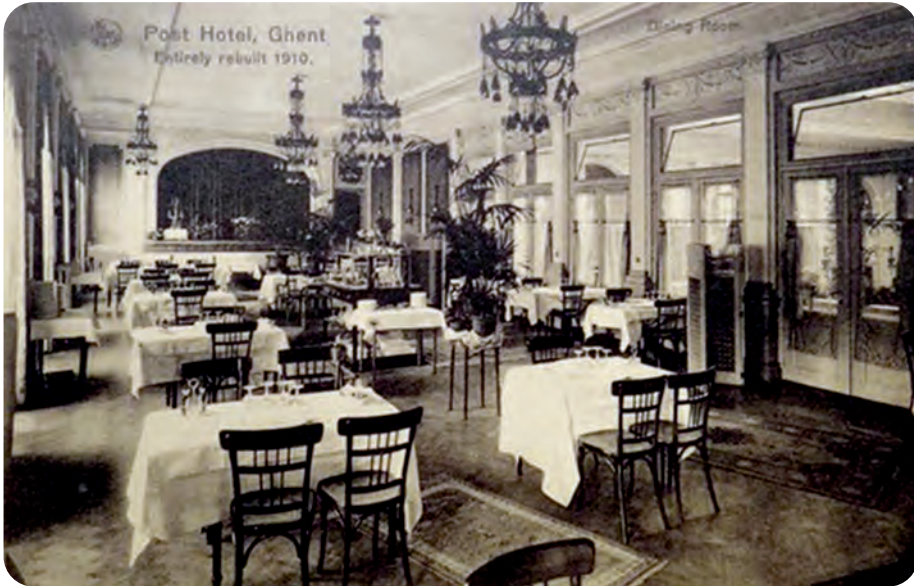
Afb. 7. Eetzaal. De positie van de orkestbak achteraan maakt duidelijk dat het hier gaat om de ruimte die initieel als balzaal was ingericht. Bron: Internet.
