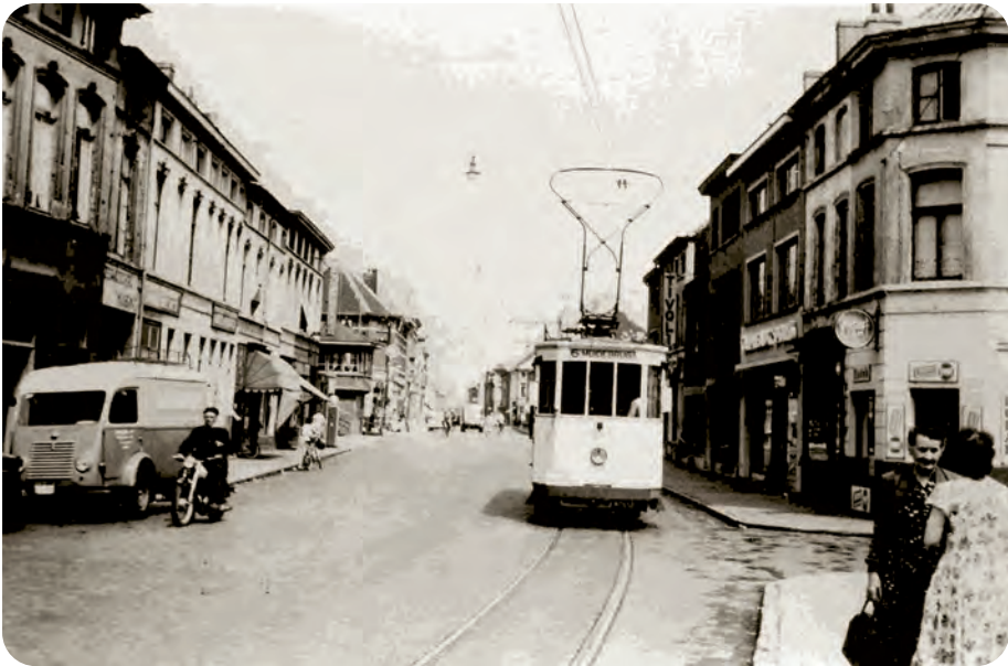
Afb. 2. Muidepoort in 1957 met zicht op de spoorwegergang toe. (privé collectie).
