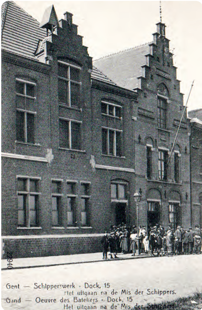
Afb. 1. Het neogotische Schippershuis met fraai gemetselde voorgevel in gele baksteen uit 1898; links het gedeelte uit 1903-1904 in roodbruine baksteen met op de eerste verdieping de schipperskapel. Onder meer de twee ingangen wijzen er op dat het geheel uit twee afzonderlijke gebouwen bestaat. De aanwezigen op de foto maken een praatje na de mis. Vanaf 1906 werden er in de kapel op zondag twee missen gelezen (verzameling Philippe Bockstael).
