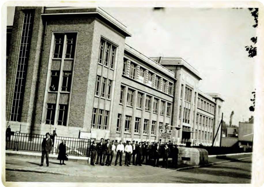
Afb. 10. De pas gebouwde Landbouwhogeschool aan de Coupure Links in 1945, toen de gebouwen door de Canadezen als veldhospitaal gebruikt werden. Op de voorgrond ziet men nog een Duitse observatiepost. Tijdens de oorlog werd de Landbouwschool onder meer ingenomen door Heeres-Kraftfahr-Park 522 en de Heeres-Unterkunftverwaltung: legervoertuigenpark en dienst voor legerhuisvesting (Stad Gent – Archief Gent).
