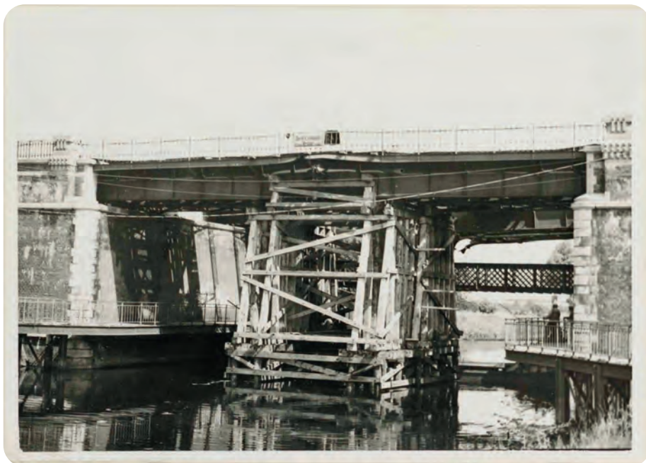
Afb. 3. De Snellespoorbrug werd op 13 mei 1940 zwaar beschadigd door een Duits bombardement op de Sint-Pietersstationswijk. Ze werd zeer snel daarna hersteld door de Eisenbahnbau Kompagnie 101 (Stad Gent – Archief Gent).
