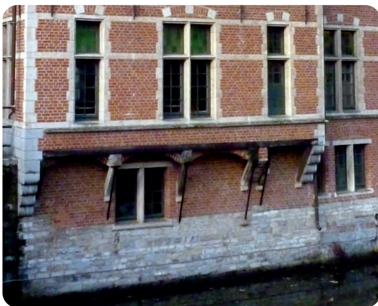
Afb. 2. Uitspringend gedeelte van de Lievegevel ondersteund door forse consoles (foto 2019) met en bekroond met een trapgevel (foto 2019).
