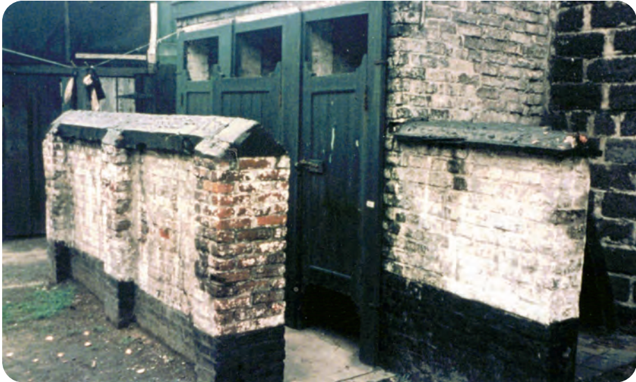
Afb. 10. Drie 'vertrekken' (zittoiletten met plank en drie gaten boven de beerput). Ze kunnen afgesloten worden met deuren die een goede verluchting (en koeling ...) toelaten. Vandaar het woord 'vertrek'. Achter het muurtje rechts vermoedelijk een pisbak (foto 1949, schenking Moreau).
