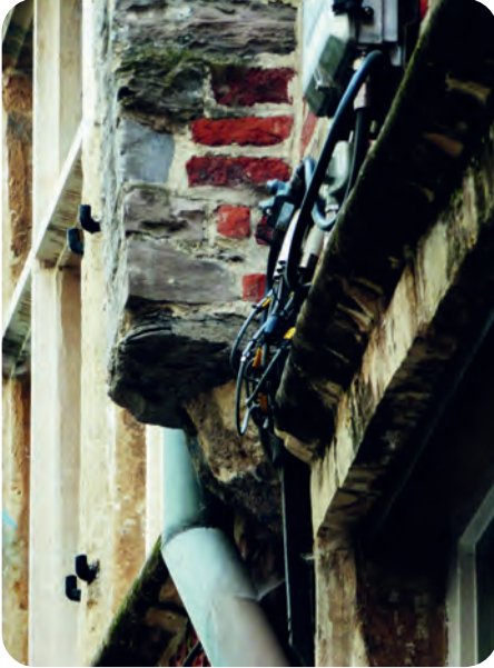
Afb. 3. Deze muurresten in het Serpentstraatje tonen hoe de (in dit geval) natuurstenen gemeene muren op de verdiepingen overkraagden (foto 2019). Op die manier kon een ‘oziedrop’ gecreëerd worden: het water drupt van de overkragende geveldelen en loopt niet langs de wand naar beneden, waardoor de dikwijls fraai beschilderde beplanking van de voorgevel minder vochtschade leed. De stenen voorgevels aan beide zijden ernaast zijn van latere datum
