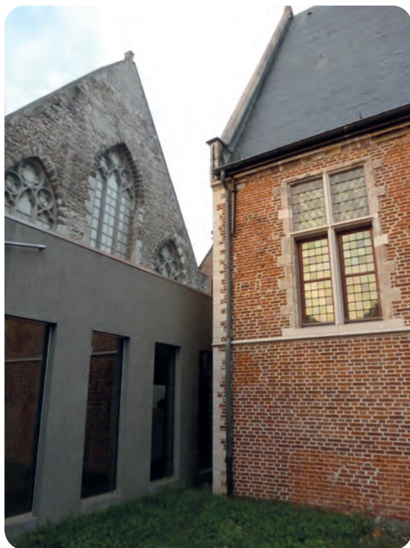
Afb. 1. Links de achtergevel van de middeleeuwse grote zaal in grijze Doornikse steen. Rechts, scherp contrasterend daarmee vanwege de bakstenen constructie, een deel van het zestiende-eeuwse Kraakhuis (foto 2018). Tussen beide (onderaan) een recente overdekte verbindende toegang. Uitwendig is het Kraakhuis moeilijk vindbaar op de Bijlokesite en voor buitenstaanders slechts gedeeltelijk zichtbaar.
