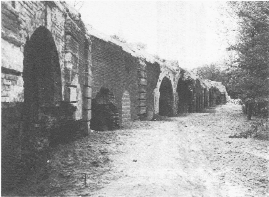
Afb. 8b. Laatste resten van de Citadel gekiekt tijdens de afbraak. Vergelijk de afbeelding met afb. 6. (Foto van de auteur)
