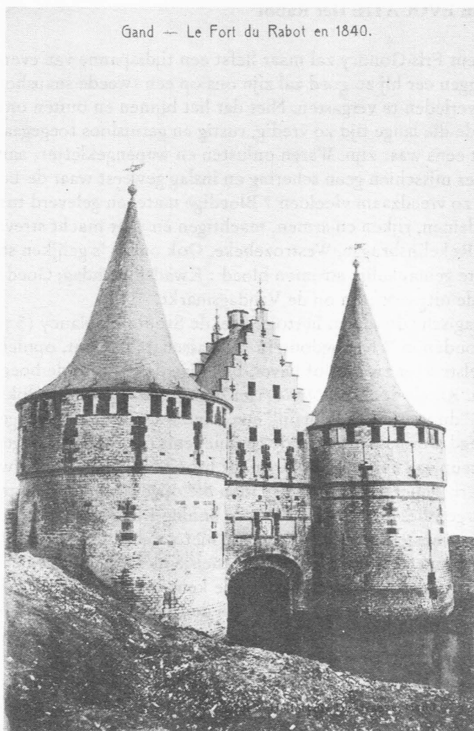
Afb. 3a. Het Rabot zoals men het kon bewonderen voor de vermindering die het in 1872 onderging. In dat jaar dolf men het onderste gedeelte van het gebouw in omdat de nabijgelegen straat diende opgehoogd te worden. Let op de twee inscripties links en rechts van de plaat waarop de Gentse Leeuw.
