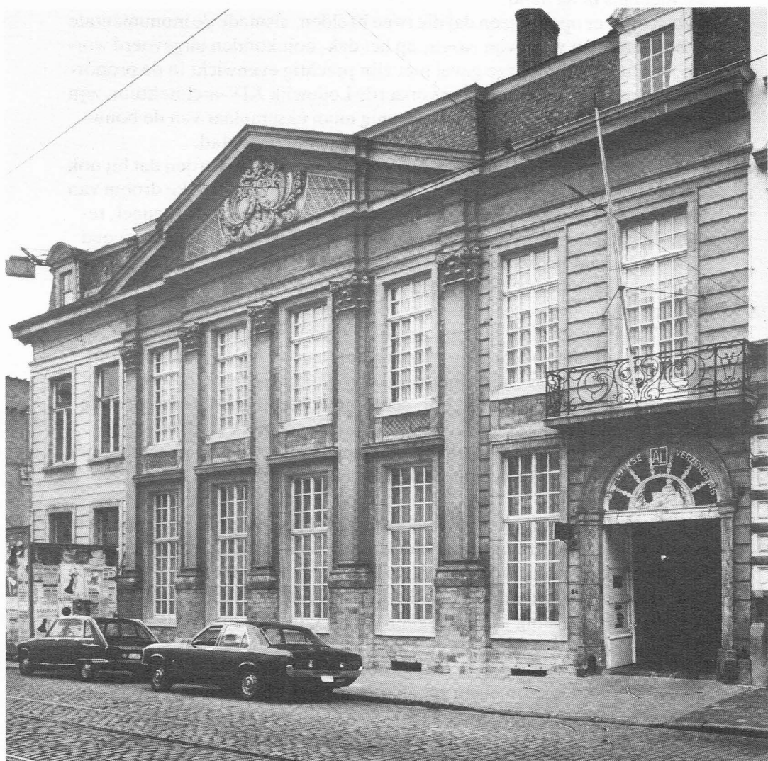
Hotel Reylof na de restauratie.
