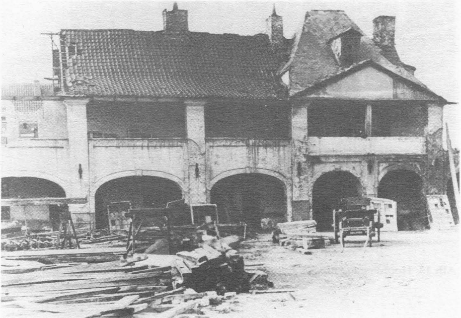
Afb.12. Afbraak v.d. kazerne 1898. De zuidergevel en poort gezien vanaf het kazerneplein en vanuit het binnenplein. (Commissie Monumenten en Stadsgezichten)
