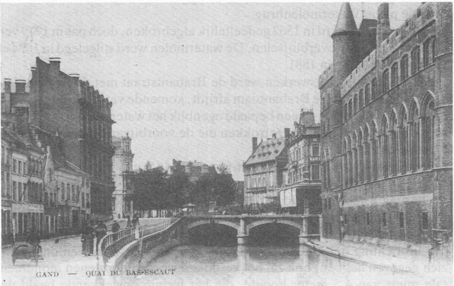
De afgewerkte overwelling, gezien aan het Geraard Duivelsteen.
