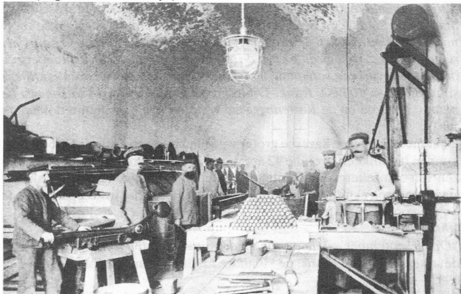
Afb. 6. Een kamer van het kelderverdiep.
