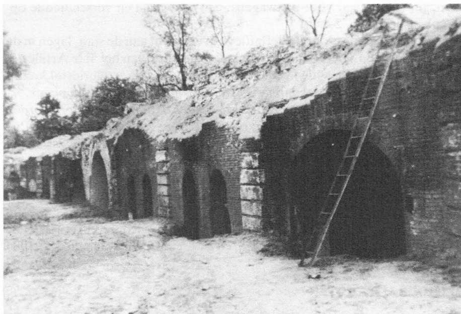
Afb. 8. Zicht vanaf de binnenplaats op de binnenwal. De opening onder de ladder is een toegang naar een der centrale gangen. De kleinere openingen zijn vensternissen van gelijkvloerse kamers. (Foto : Van Wesemael 1950)
