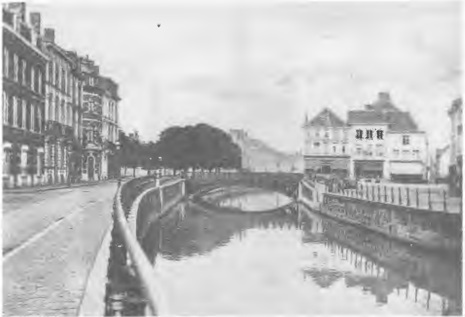
Afb. 8. De Nieuwbrug gezien vanaf de Reep. De huizen rechts verdwenen voor de bouw van het RTT gebouw (1974-1975).
