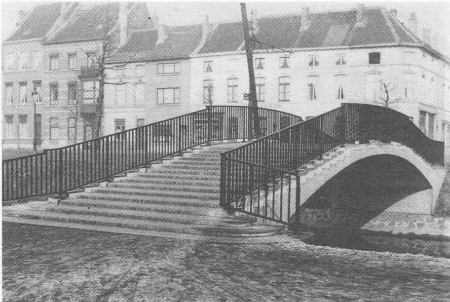
Geuzenbrug in 1949. (Foto T.D. van Bruggen en Waterloper).
