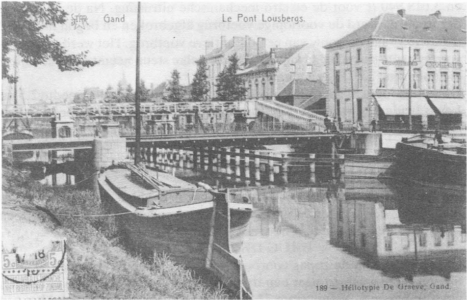
Lousbergsbrug en voetgangerspasserel omstreeks 1910.
