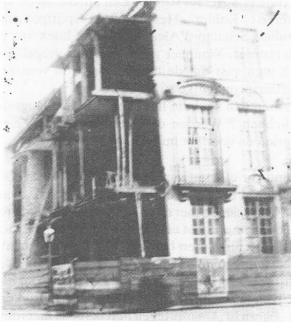
3. Werken aan het Hotel Schamp-d'Alcantara.
