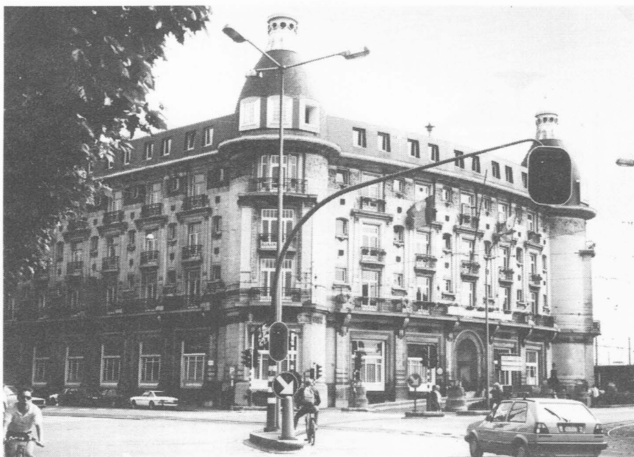
Fig. 12. Het "Flandria - Palace" aan het St.-Pietersstation. Eens het grootste hotel van Gent om de stroom bezoekers van de Wereldtentoonstelling van 1913 te kunnen verwerken. Het had nog een flinke reservevleugel die tijdens de oorlog 1914-1918 als transit gevangenis voor opgeëiste werklieden gebruikt werd. Het hoofdgebouw was toen als Kriegslazarett "Flandria" in gebruik. Thans is er het handelscentrum van de spoorwegen gevestigd. (Foto E. Levis juli 1988, eigen verzameling.)
