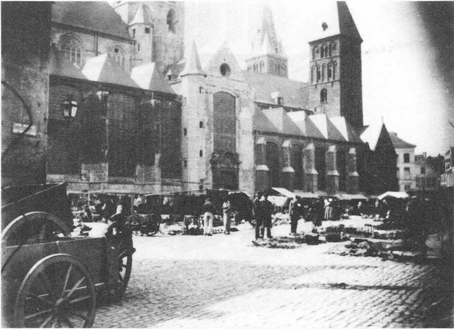
Fig. 1. De Rommelmarkt gezien van op de Kleine Botermarkt. Men bemerkt het straatnaambord uiterst links op het thans afgebroken huizenblok naast de oude stadsbibliotheek. De restauratiewerken aan de Sint-Jacobskerk zijn aan de gang. Een balk met katrol steekt uit het linker torenvenster. De zijgevel heeft ook nog steeds geen spitsboogvensters. Het middenplein is nog niet aangelegd en er staan nog geen bomen gepland. De foto is genomen tussen 1890 - herstelling van de toren - en 1892 - restauratie van 10 vensters van het kerkschip en 2 portalen. Fotograaf onbekend. (Verzameling E. Levis).
