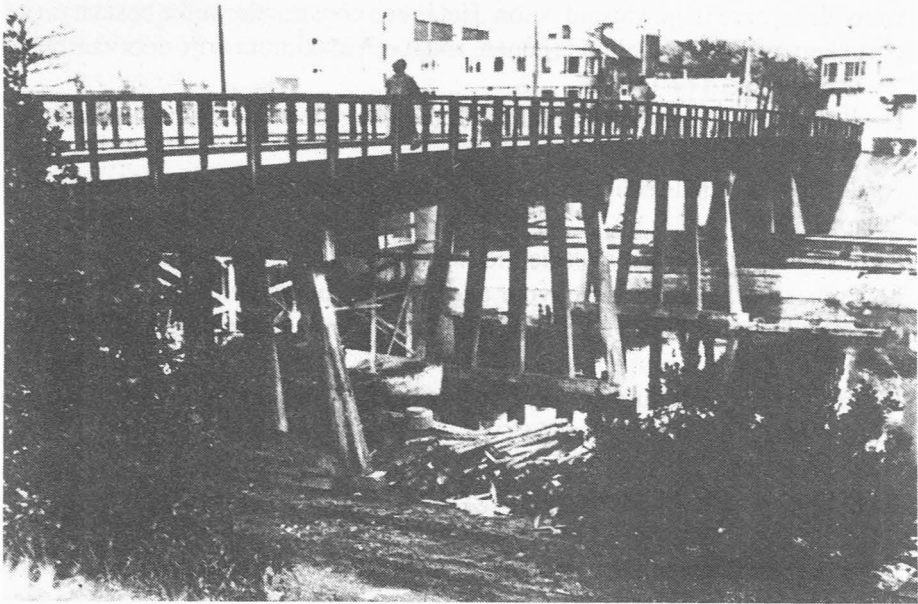
De noodbrug op de plaats van de verwoeste Koning Albertbrug. Deze noodbrug deed dienst van 1940 tot 1952 (foto dienst Monumentenzorg).
